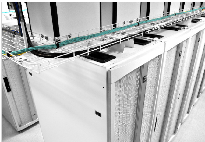
CPI OnTrac 金属网格式缆线桥架为数据中心的网络缆线提供点对点布线路径。
