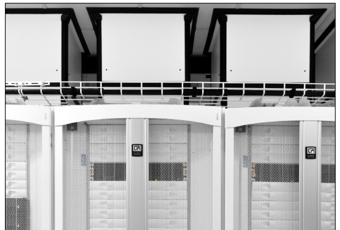
CPI 排气管引导热废气从机柜背部排入吊顶压力通风系统，从而为冷却系统创造封闭的热气返回路径。
