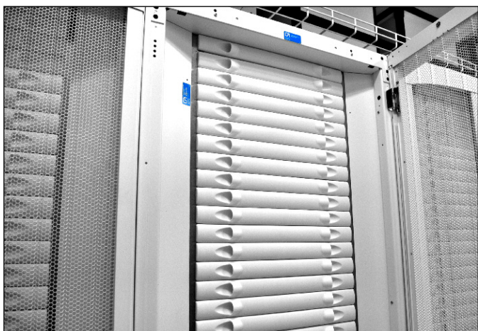
CPI 快速拆卸式盲板上的高效密封件可防止热空气在盲板之前循环流动。
