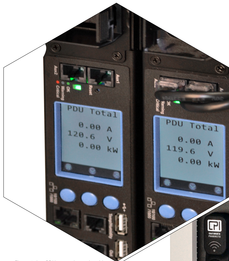
Figura 8: Las PDU montadas en bastidor distribuyen la energía a los equipos dentro del contenedor y pueden permitir un monitoreo remoto de energía y control de salida. Foto de las Switched Pro eConnect PDU® de CPI.
