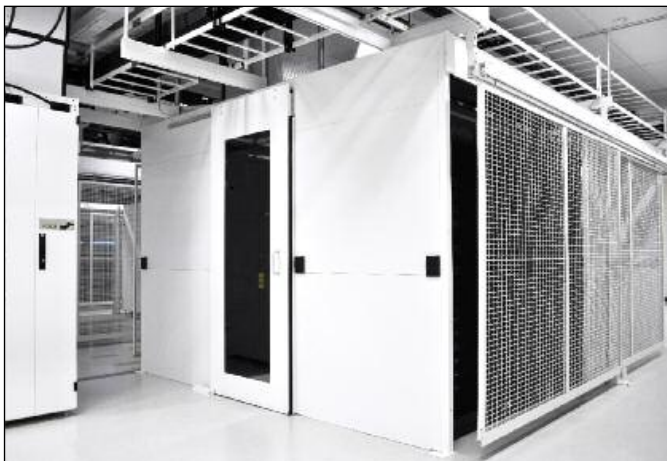
Para crear la flexibilidad y seguridad necesarias en una instalación de colocación, Vault implementó la utilización de centros de datos de rendimiento optimizado, también conocidos como POD.
