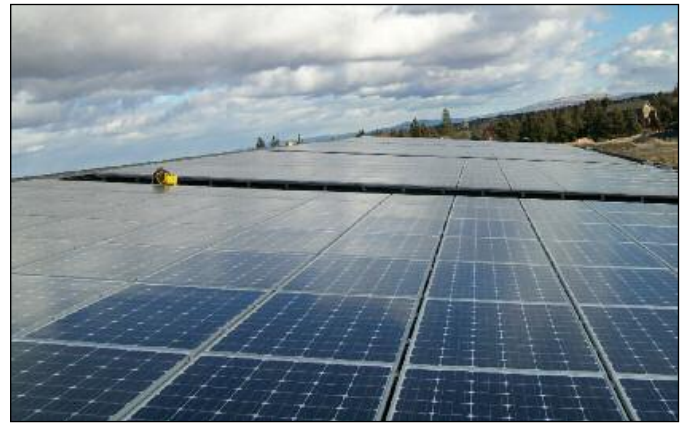
La lista de iniciativas verdes de Vault incluye créditos de carbono, materiales de construcción reciclados y el uso exclusivo de energía renovable de la compañía de servicios local, como así también un panel solar de 152 kW colocado en el techo de la instalación.
